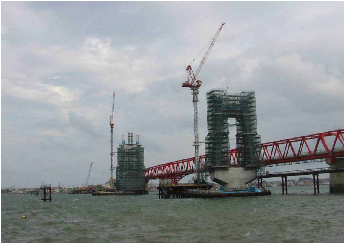
新銚子大橋 建設中
